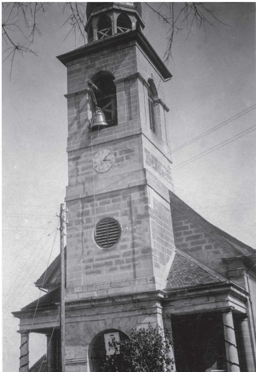
Installation et inauguration des deux cloches le 10 mai 1931. La cloche 1 dédiée à la Trinité (MI) et la cloche 2 dédiée à sainte Marie (FA dièse).
